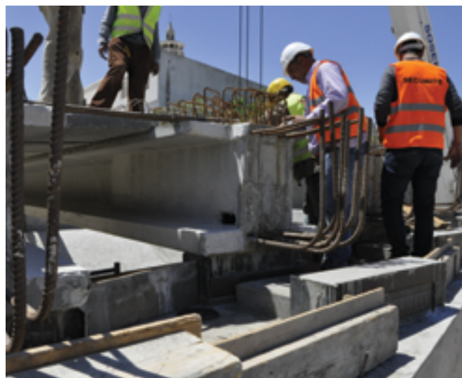
TECNIS – Fourniture de poutres de portée 20 m pour le tablier d'un pont – Projet R.F.R. Ligne D - Tunis
