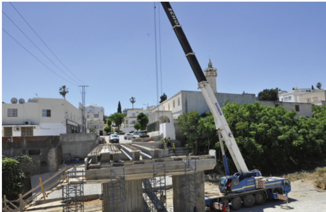
TECNIS – Fourniture de poutres de portée 20 m pour le tablier d'un pont – Projet R.F.R. Ligne D - Tunis
