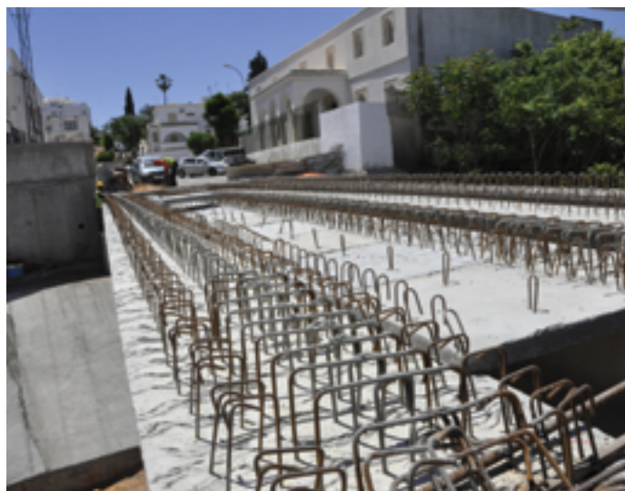
TECNIS – Fourniture de poutres de portée 20 m pour le tablier d'un pont – Projet R.F.R. Ligne D - Tunis
