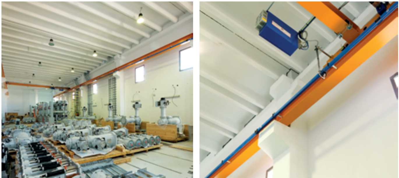
CTE – Poste blindé haute tension – Sousse - Bâtiment Industriel de 1.300 m² avec mur pare-feu de 180 minutes Entreprise Générale : Siemens - Maitre d'Ouvrage : STEG
